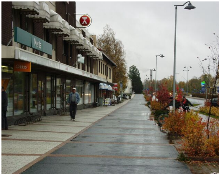
Kuva 10 Keskustaväylän saneeraus. Väylän saneerauksen yhteydessä tien tasausta nostettiin, jotta kiinteistöihin saatiin esteettömät sisäänkäynnit. Oulun tiepiiri, Muhos
